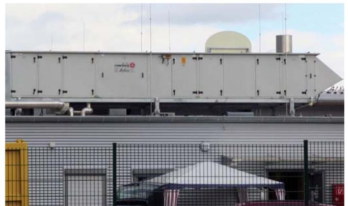
Des Weiteren rüsten wir wetterfeste Geräte mit einigen besonderen Zubehörteilen aus. Zur Verhinderung des Eintritts von Niederschlag in die Außenluftöffnung und die Fortluftöffnung bieten wir strömungsgünstig konstruierte Hauben und Wetterschutzgitter an. Durch zusätzliches Einfügen eines Tropfenabscheiders an der Außenluft-Ansaugöffnung kann das Gerät zusätzlich vor dem Eintritt von Feuchtigkeit geschützt werden.
